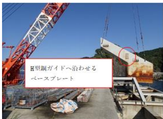
図 1 9 空気室撤去状況
