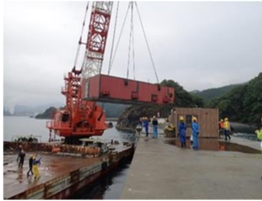
図1 5 機械室（発電機含む）の搭載
