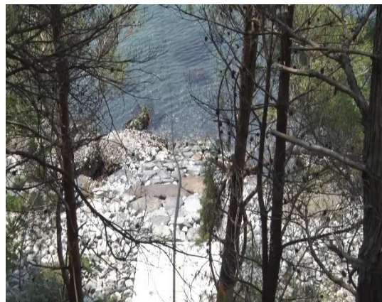
図11 海底ケーブルの設置（陸側）
