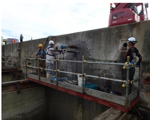
図 2 3 アンカーボルト撤去状況（側壁）
