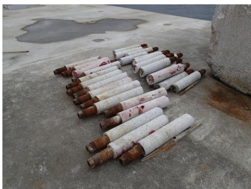
図 2 5 撤去アンカーボルト（31本）
