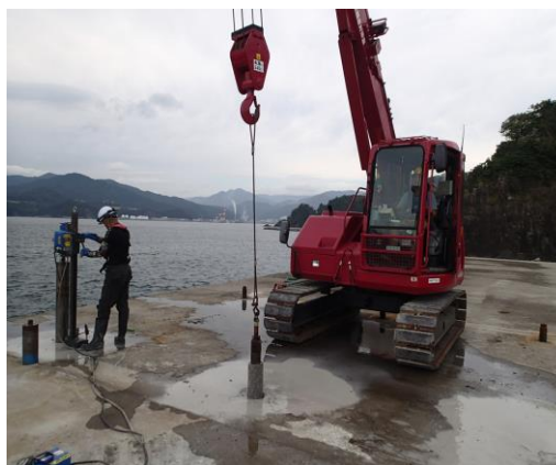
図 2 2 アンカーボルト撤去状況（上部工）
