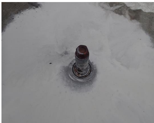
図 2 1 撤去前アンカーボルト
