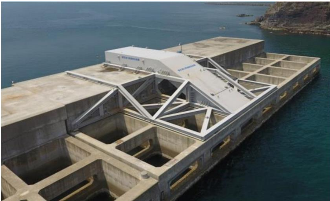
図1 6 システム完成全景
