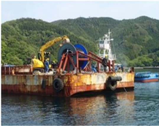
図10 海底ケーブルの敷設
