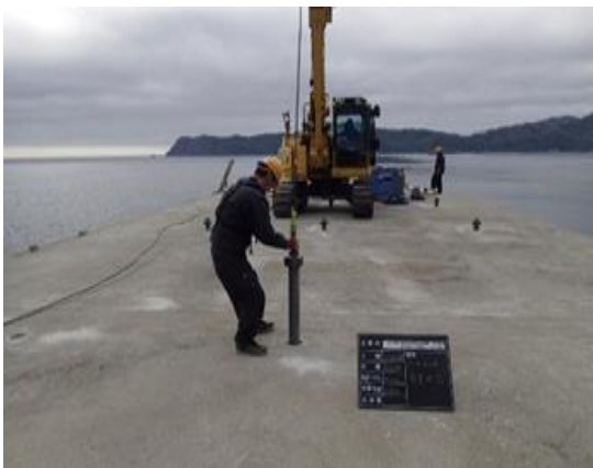
図12 アンカーボルトの設置（上部工）
