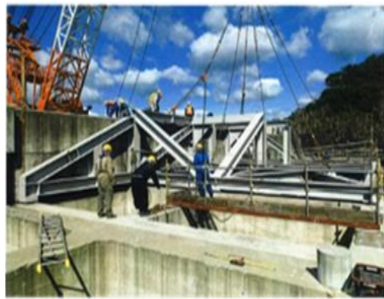
図13 H型鋼フレームの設置
