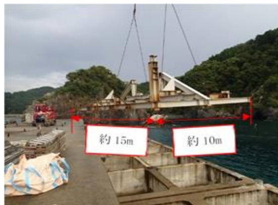
図 2 0 H 形鋼フレーム撤去状況
